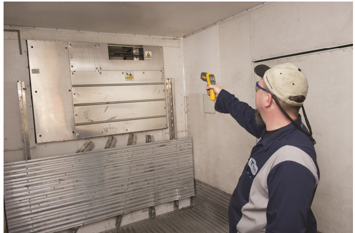
外部制冷机组可能看起来工作正常，但机组的输出温度不足够低。布拉德利用 Fluke 561 红外与接触式测温仪检查温度。
